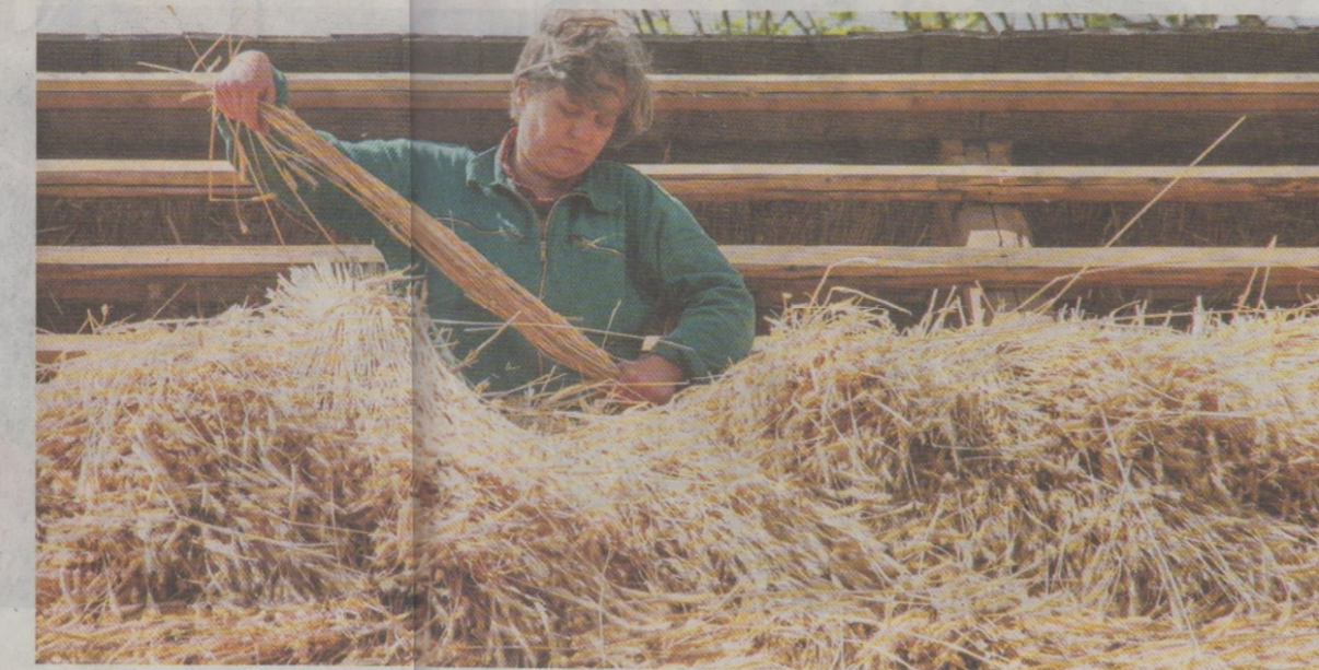
Eine Fachfrau in ihrem Element: Friederike Seedorf deckt das Weberhaus nach einer jahrhundertealten Arbeitsmethode mit Stroh.
