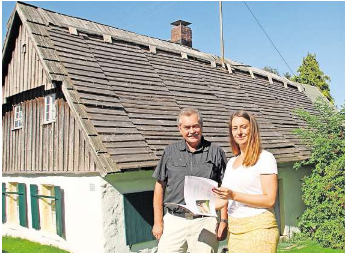
Bettina Nagler und Edwin Greim vor dem zurzeit mit Holzplatten abgedeckten Weberhaus in Kleinschwarzenbach. Im Sommer oder Herbst des nächsten Jahres will man das Satteldach wieder mit Stroh eindecken. Foto: -ts-r
