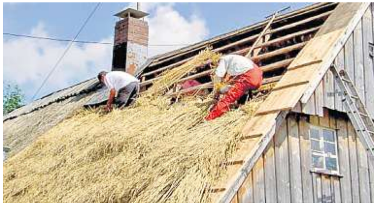
Ein Strohdach besteht aus gebundenen Schaben, also geordnete und verdrillte Strohbüschel, die auf dem Dach befestigt werden. Gut 1800 solcher Schaben kommen aufs Dach des Kleinschwarzenbacher Weberhauses. Foto: Privat
